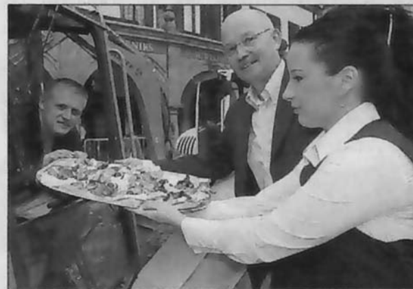
Von Veranstaltungsmanager Bernd Hochmuth (M.) gibts eine Stärkung für Bagger-Fahrer und Bauleute, damit sie bis zum Stadtfest auf dem Markt fertig sind. Foto: M. Däberitz
